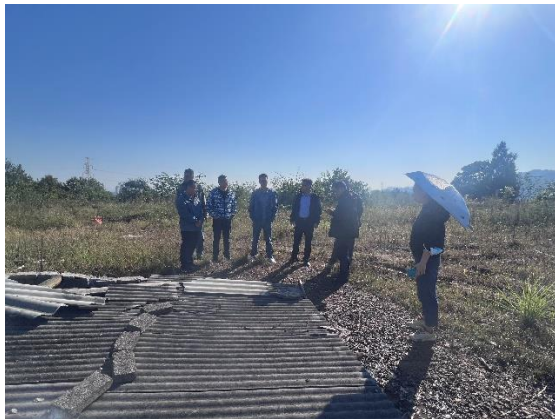
图 1-4 六里河页岩气井踏勘现场
